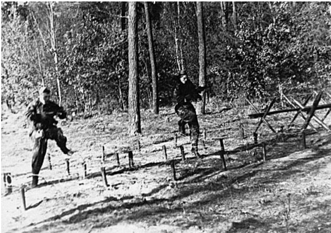
Рис. 16 проволочный забор на низких кольях в три ряда и способ его преодоления длина - 20 м, ширина - 4,5 м
