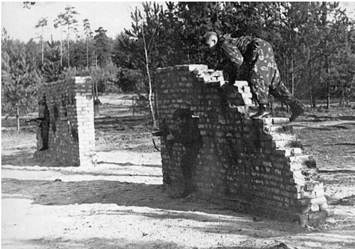
Рис. 2 кирпичные стенки с проломами длина одной стенки - 4 м, высота - 2 м
