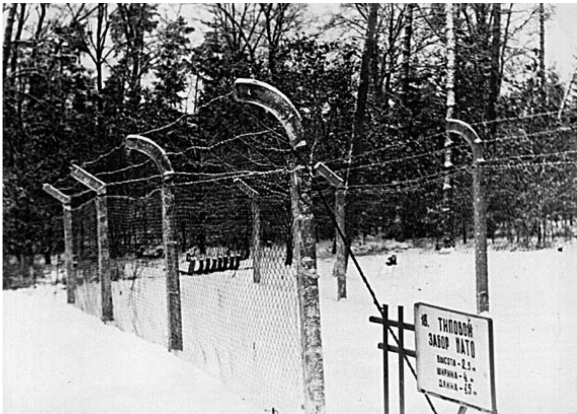
Рис. 18 типовой забор НАТО длина 15 м, высота - 2,5 м, ширина - 4 м
