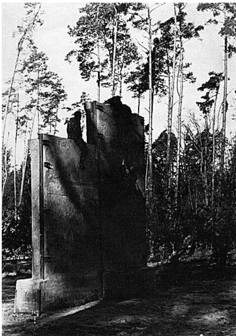
Рис. 10.2 бетонная стенка ширина - 5 м, высота - 4,5-6 м
