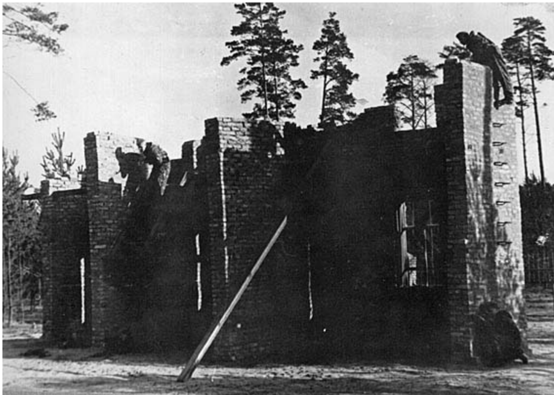
Рис. 4.1 способы преодоления полуразрушенного здания
